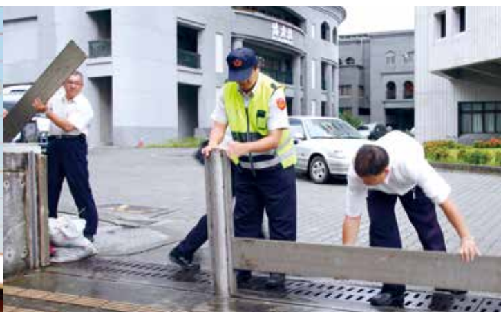
總務室警勤組同仁正在放置地下停車場入口的防水擋板。攝影 / 彭微勻
