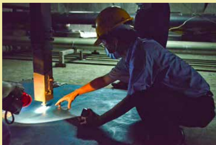
地下隔震系統中會設立位移指針來檢驗地震後建物與隔震墊承受的應力是否都被吸收與消耗，臺北慈院位於地震頻繁的臺灣，位移指針仍回復原點，令檢核工程師大為讚嘆。攝影／徐莉惠
