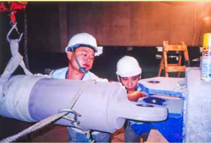
工程領班周正鵬微微移動一點八四公噸重的「液壓桿阻尼器」，對準「鎖」孔。攝影／劉鼎龍
