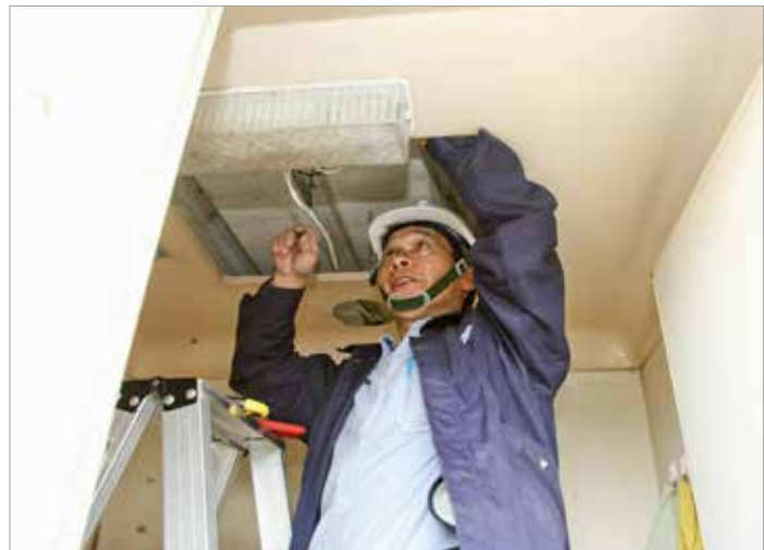
工務室組長余許富將廁所電燈接上電，並仔細進行確認。
