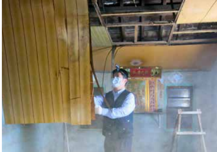
同仁將殘破不堪的天花板拆除，換上全新的木板。
