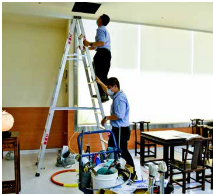
工務室游富升（前）與同仁進行電線配置作業。
