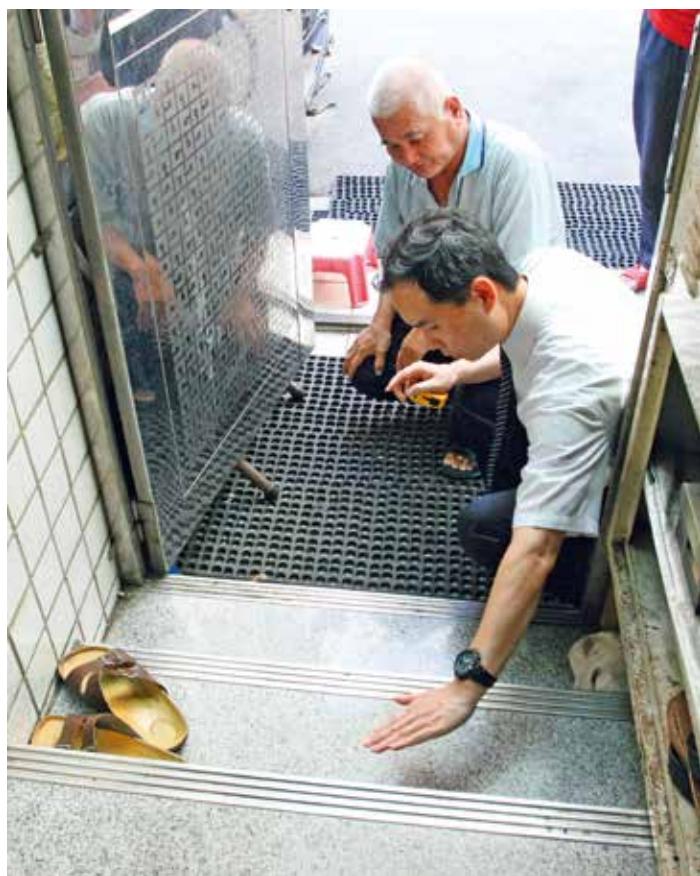
復健科蔡森蔚主任正在與江爸爸討論，將門前的階梯改為坡道的處理方式。
