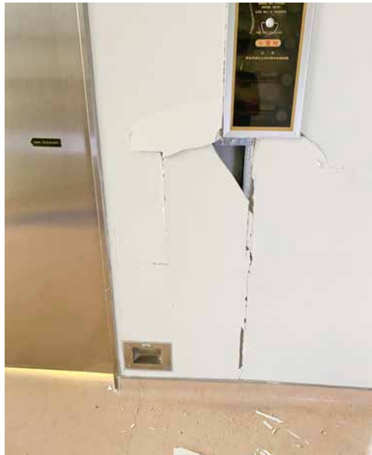
九一八強震造成玉里慈院開刀房牆面磁磚脫落、隔板龜裂。攝影／葉雲鑑
