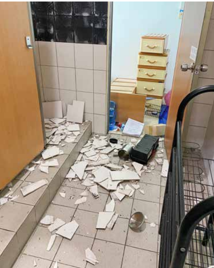
九一八強震造成玉里慈院開刀房牆面磁磚脫落、隔板龜裂。攝影／葉雲鑑
